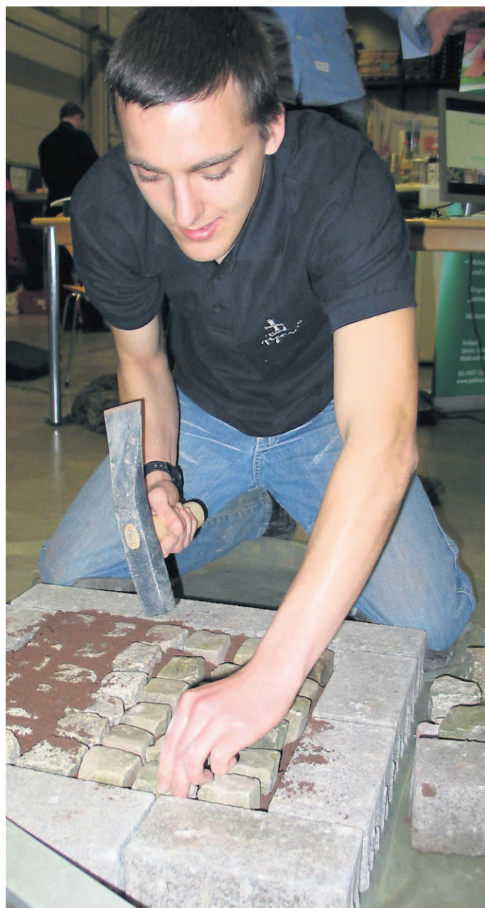
Handfestes Handwerk: Alexander Conradi, der im Bauhof der Stadt Bad Pyrmont Landschaftsbauer lernt, demonstriert, wie er fachgerecht ein Steinpflaster anlegt. Fotos: heb
